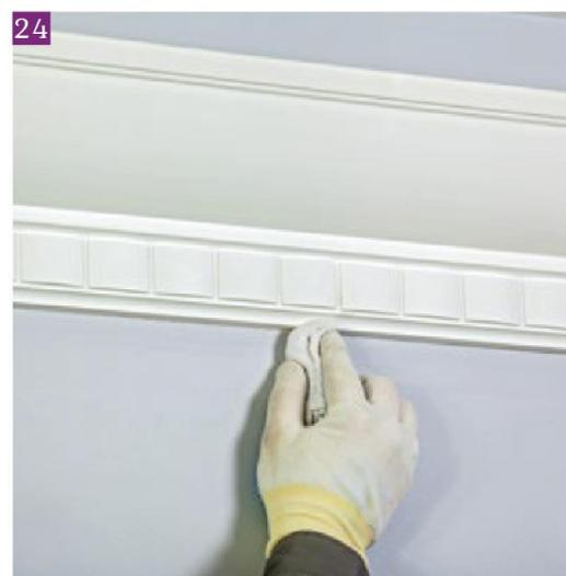
21. Мелкозернистой наждачной бумагой обработать стыки до получения ровной поверхности.
