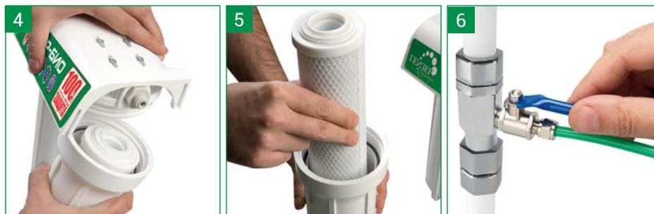
После установки нового фильтра или смены картриджей в системе остается воздух. Это приводит к избыточной аэрации воды (визуально вода может иметь молочно-белый цвет). По мере работы фильтра воздух из системы уйдет, и очищенная вода будет прозрачной.
