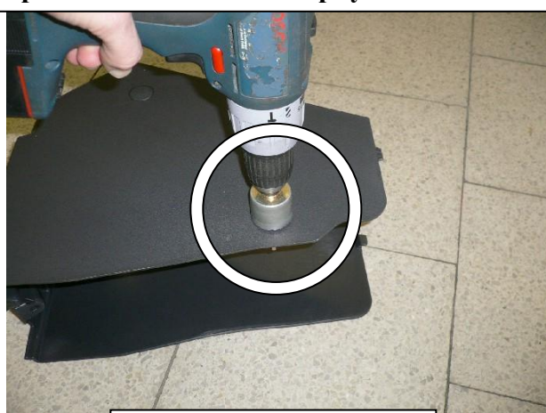
Расширить отверстие
