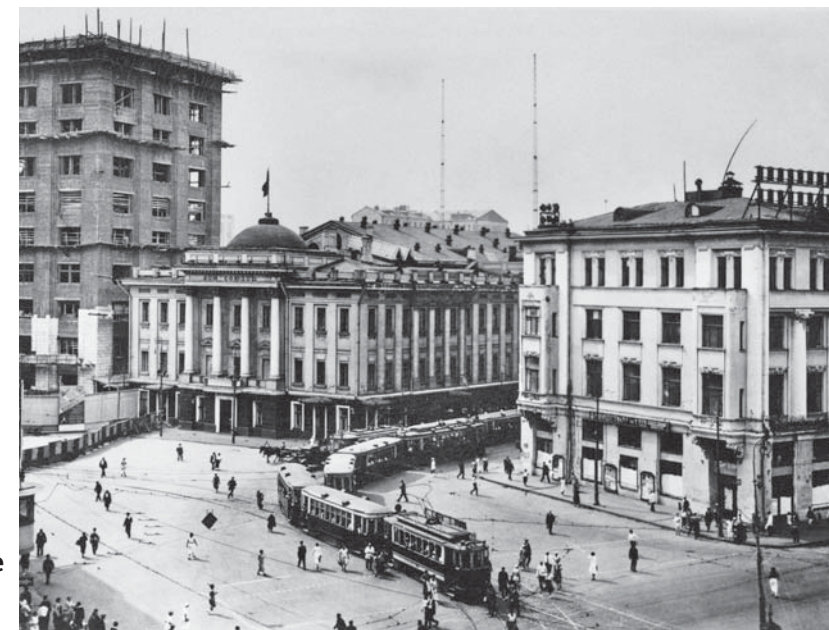
На строительстве Дома СТО, 1930-е годы
