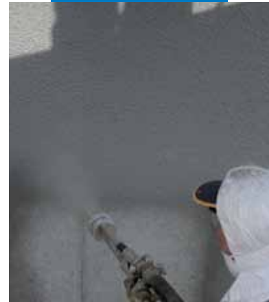
Нанесение Mapelastic на виадук путем распыления
